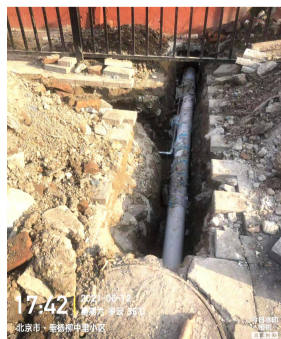
上下水管线改造
